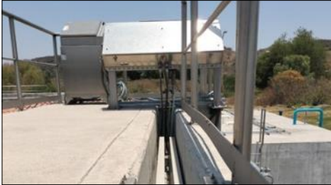
La desinfección permite desactivar o destruir los posibles microorganismos patógenos; en este caso se muestra el proceso con Rayos Ultravioleta.
