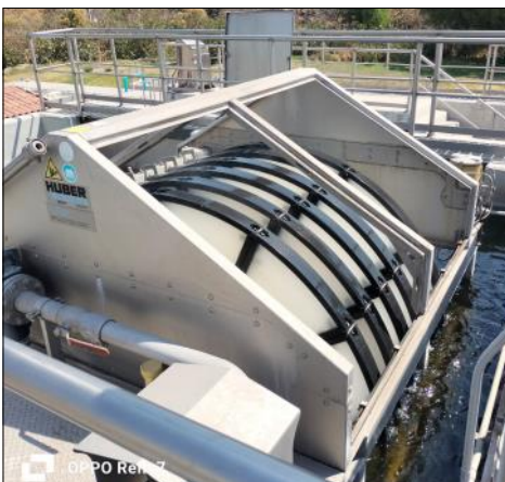
El tratamiento terciario; en esta caso con filtros, proporciona una calidad aún mejor.
