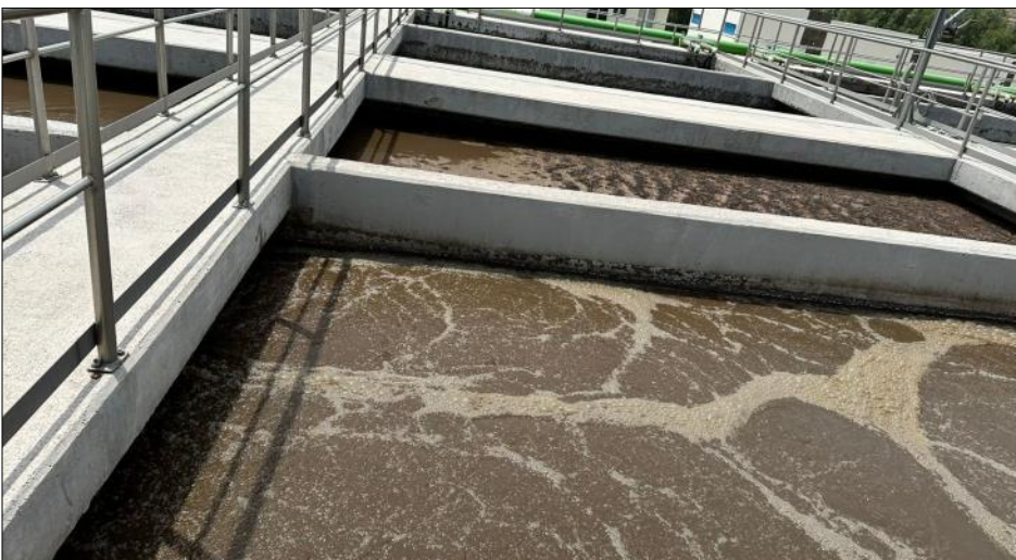
Tanque de aireación, donde un conjunto de bacterias realiza la degradación de la materia orgánica. En ellos se puede observar el burbujeo que produce el aire (oxígeno) inyectado.
