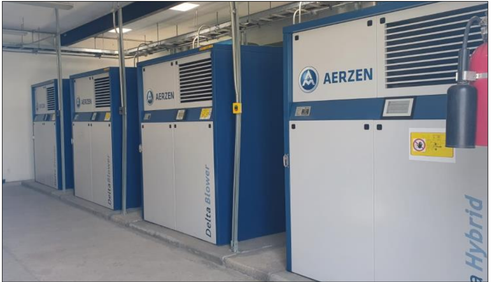
Parte del equipo que se utiliza para inyectar aire (oxígeno) en los tanques digestores.
